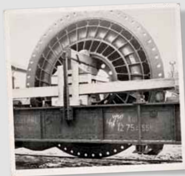
Das Primärschaufelrad (die Pumpe) der Anfahrkupplung für das Pumpspeicherwerk Herdecke.
