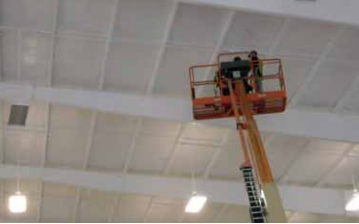
Abb. 4: Besseres Licht, 25 % weniger Energie: effiziente Beleuchtung in West Monroe, USA.
